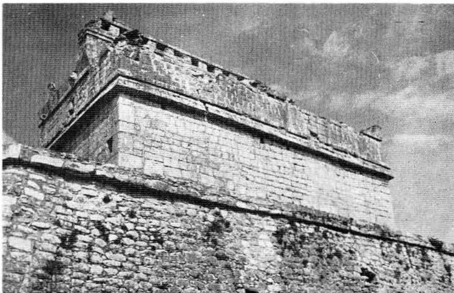
Lám. II. El mismo lado después de su consolidación.
