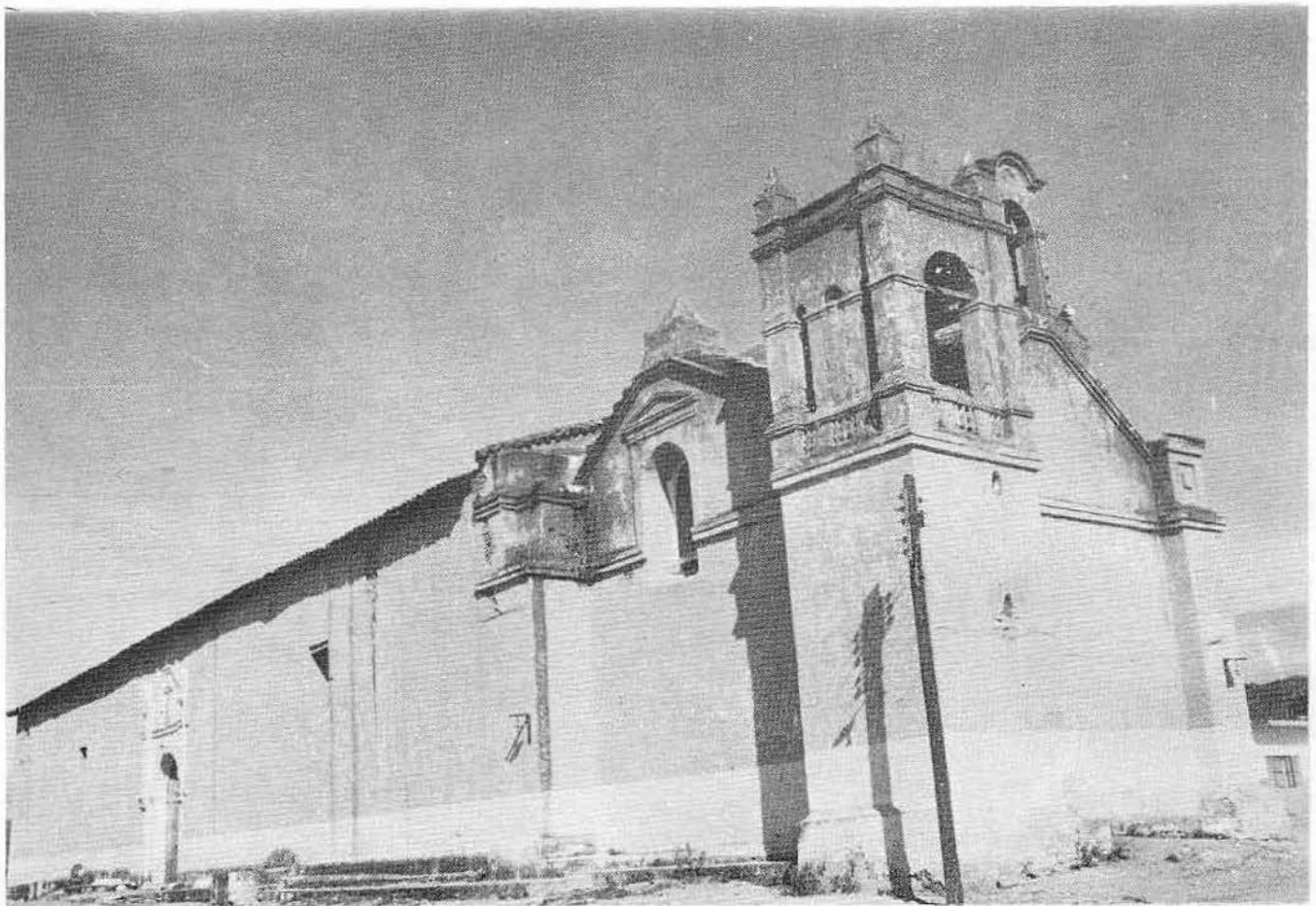
Foto 3. La "Visita" de San Esteban Suchiapa nos muestra su elegante ábside característico de las construcciones religiosas de su Vicaría, junto con la diminuta torre-campanario en doble función: Como tal y como contrafuerte para recibir los empujes de la bóveda estrellada que cubre el presbiterio.
