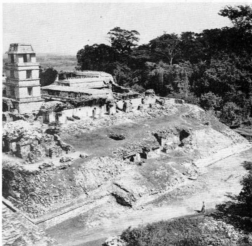
Fig 23. El mismo lado sur de El Palacio, una vez que se dieron por terminados los trabajos de exploración
