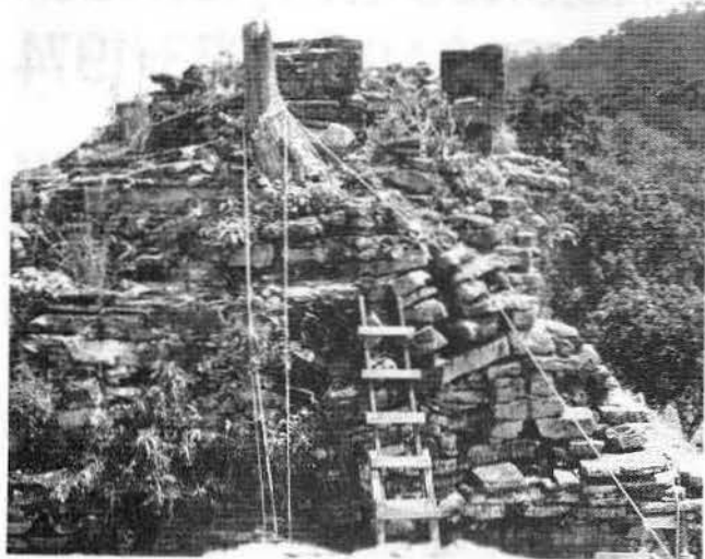
Fig 1. Vista en que se aprecia el techo del Templo IV, antes de las obras de consolidación. La raíz de un árbol se había integrado de tal forma que tuvo que conservarse
