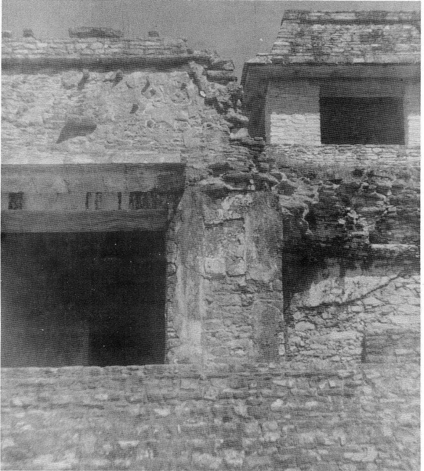
Fig 17. Alero del último pilar en el lado oeste de El Palacio. Al igual que en el ángulo noroeste, se optó por hacer en los aleros un colado que simulara losas auténticas
