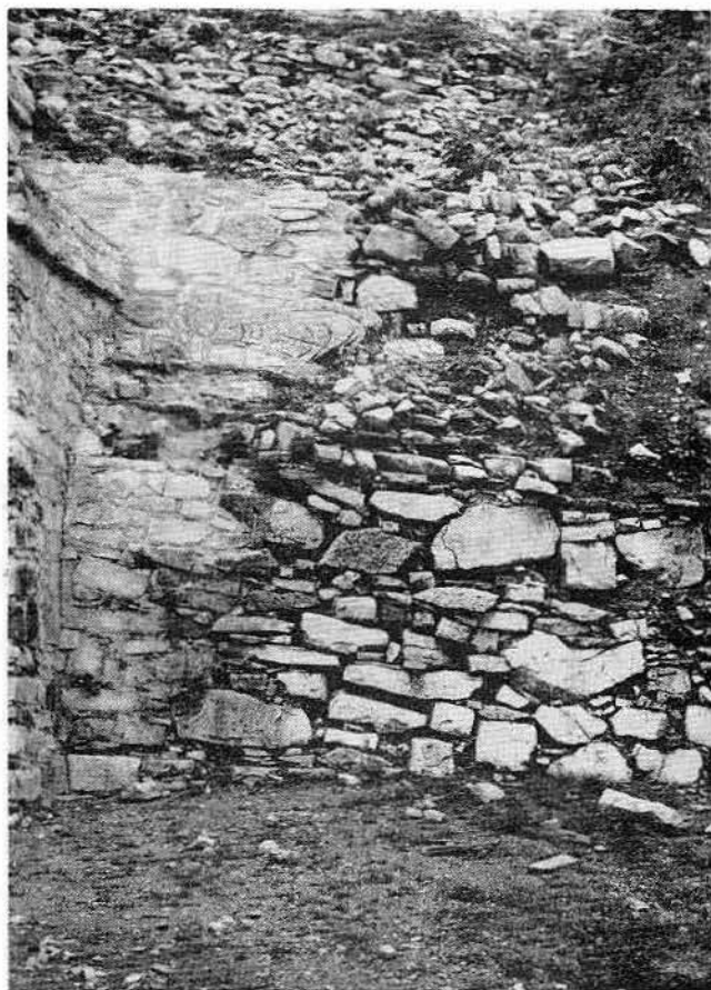
Fig 35. Junto al ángulo noroeste del Templo de las Inscripciones, se halló un muro construido con grandes piedras, algunas de las cuales llegan a medir 1.25 por 0.77 m
