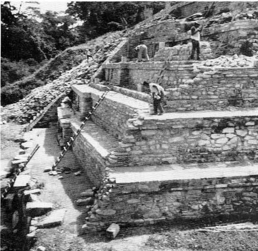
Fig 14. Varios de los cuerpos del lado norte de El Palacio fueron reconstruidos hasta su altura original
