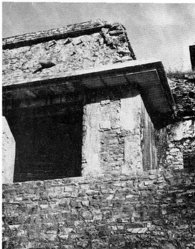
Fig 18. Alero del último pilar en el lado oeste, ya restaurado. Era urgente la restauración de los aleros, pues en la temporada de lluvias el agua caía sobre los estucos
