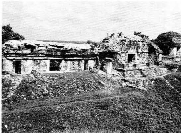
Fig 4. Con excepción del Templo II, en todos los edificios del Grupo Norte se consolidaron los techos. Aunque parecía sencilla, la consolidación in situ resultó muy laboriosa
