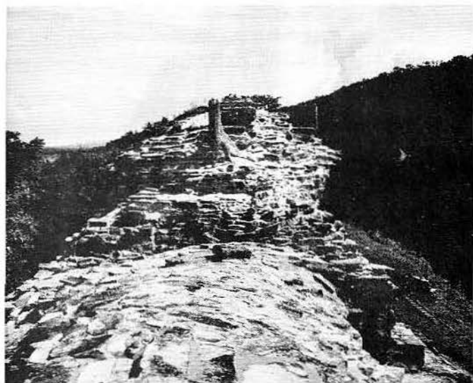
Fig 3. En esta vista general puede verse la parte superior de los techos de los Templos IV y V. Para su consolidación solamente se colocó cemento alrededor de las piedras caídas
