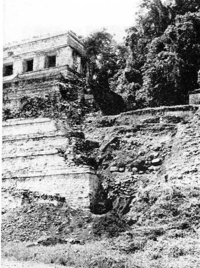
Fig 36. Angulo noroeste del Templo de las Inscripciones, antes de iniciarse los trabajos de restauración. La parte superior apareció muy destruida, según puede apreciarse
