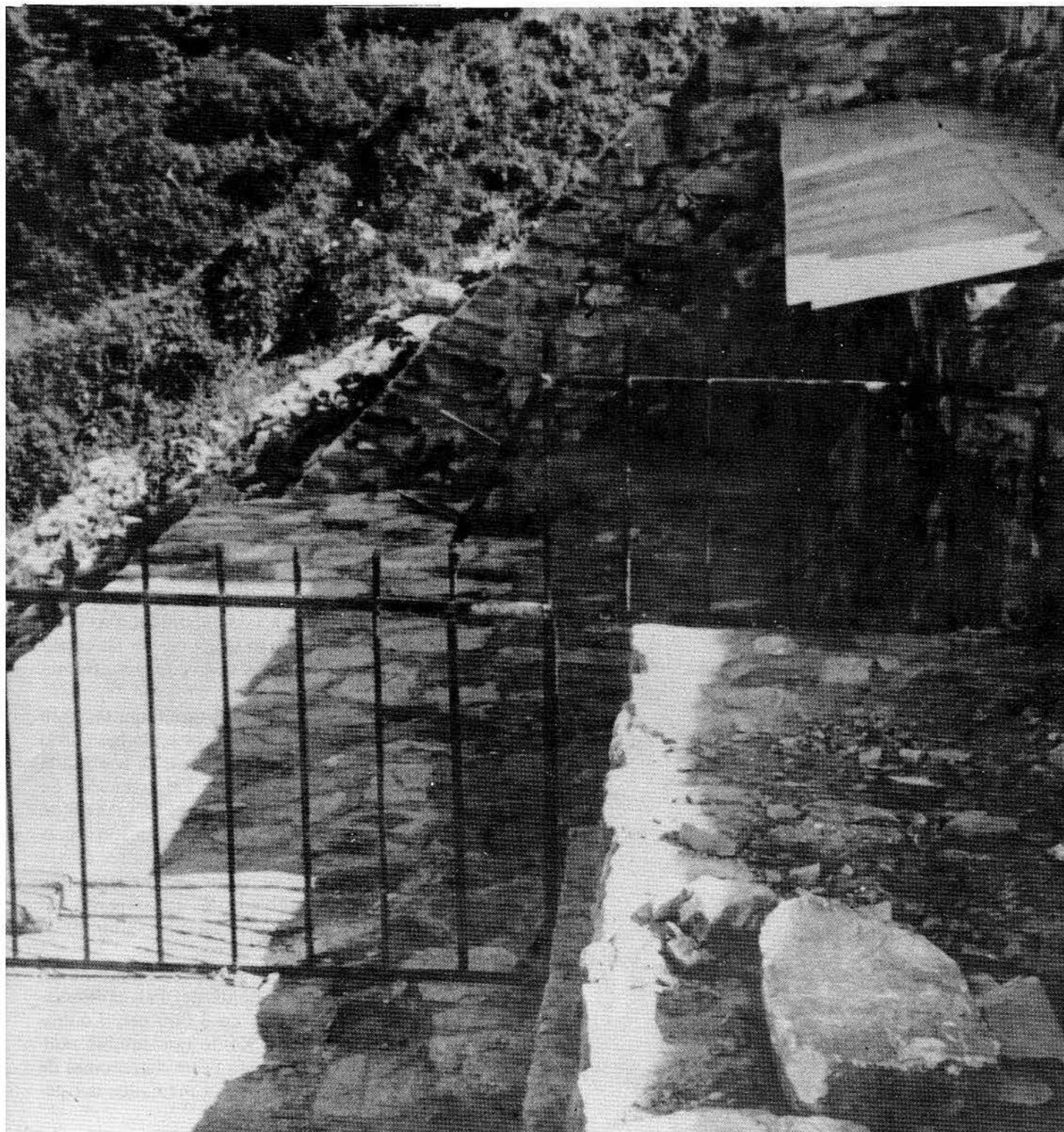
Fig 32: Aprovechando la presencia del herrero, en esta temporada se construyó también una reja metálica para el Templo XIV. La lámina translúcida da mejor iluminación
