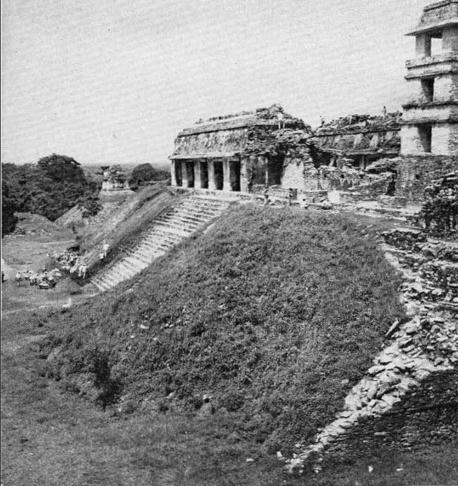
Fig 1. Este es el aspecto que presentaba la escalinata de El Palacio antes de las restauraciones realizadas por el Departamento de Monumentos Prehispánicos del INAH, durante la temporada de agosto-noviembre de 1968
