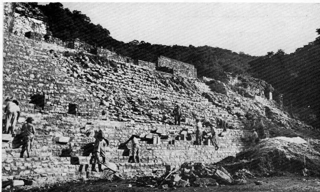
Fig 8. Restaurada la sección norte de El Palacio, se pasó al extremo sur. El estado de la escalinata no era mejor: la yerba cubría una buena parte de los escalones y muchas de las piezas habían desaparecido, por distintas razones
