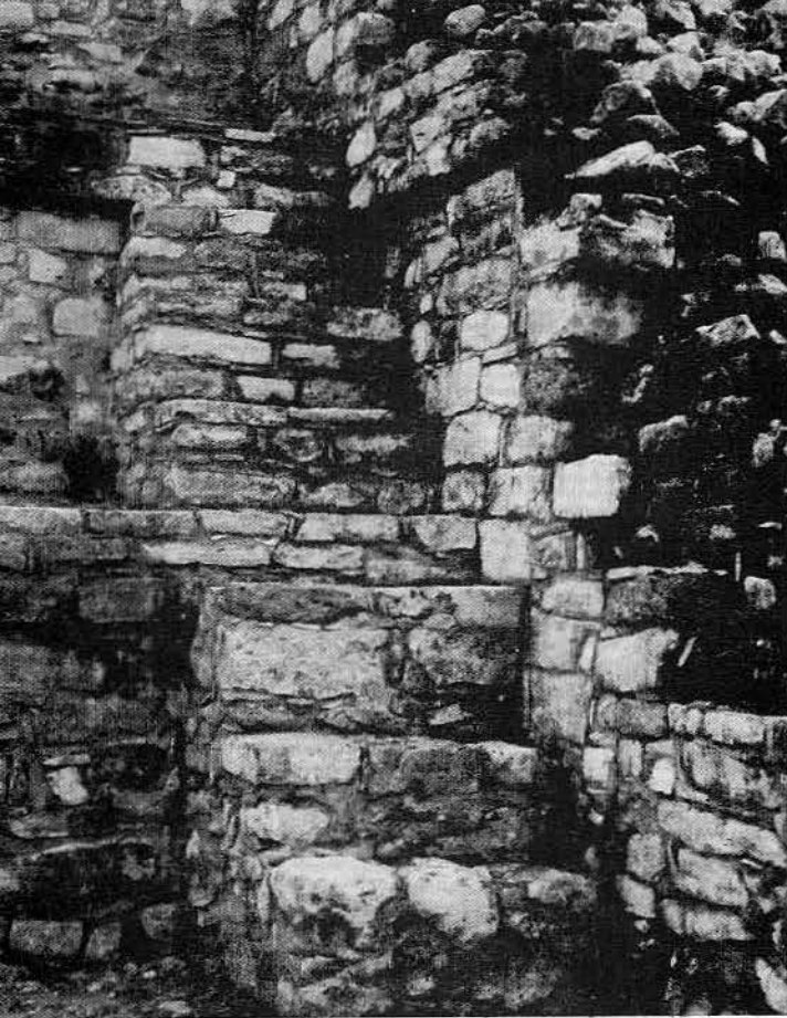
Fig 4. Una alfarda que se encontró en el transcurso de la exploración, permitió confirmar que no todos los escalones llegaban hasta el extremo norte de la construcción y que éstos habían pertenecido a etapas por completo diferentes
