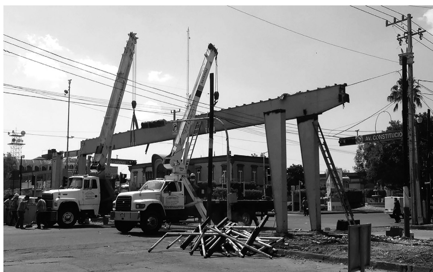
Figura 5. Retiro del puente peatonal en la intersección de Lázaro Cárdenas y Constitución, en Sahuayo, Michoacán, para ser sustituido por un cruce semaforizado a nivel de calle.
