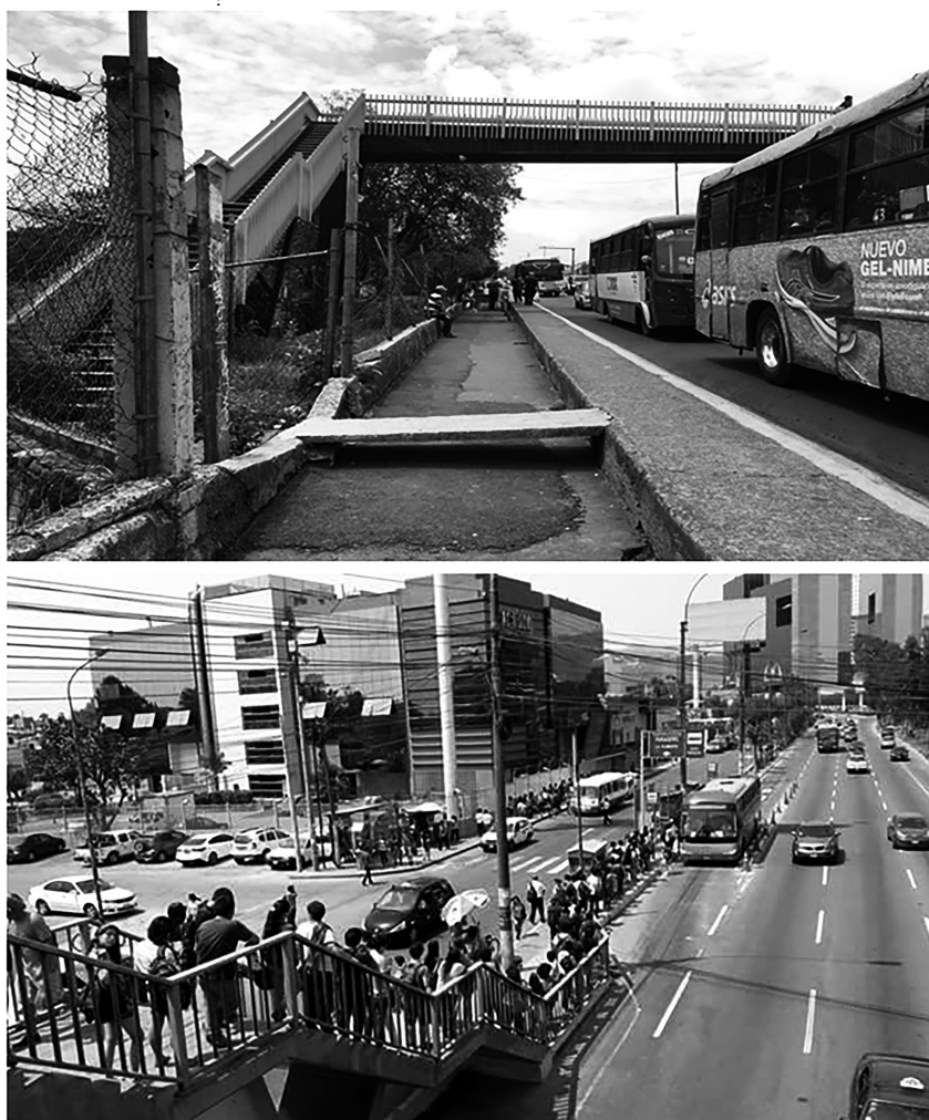
Figura 2. Infraestructura de accesibilidad y mezcla de usuarios en puentes peatonales. Arriba: Héroes de Padierna, Tlalpan, Ciudad de México; abajo: avenida Javier Prado Este, cuadra 33, Lima, Perú.
