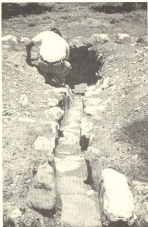
Fig. 13. Canal para desalojar el agua de lluvia de la Plaza Central. Tres Cerritos.
