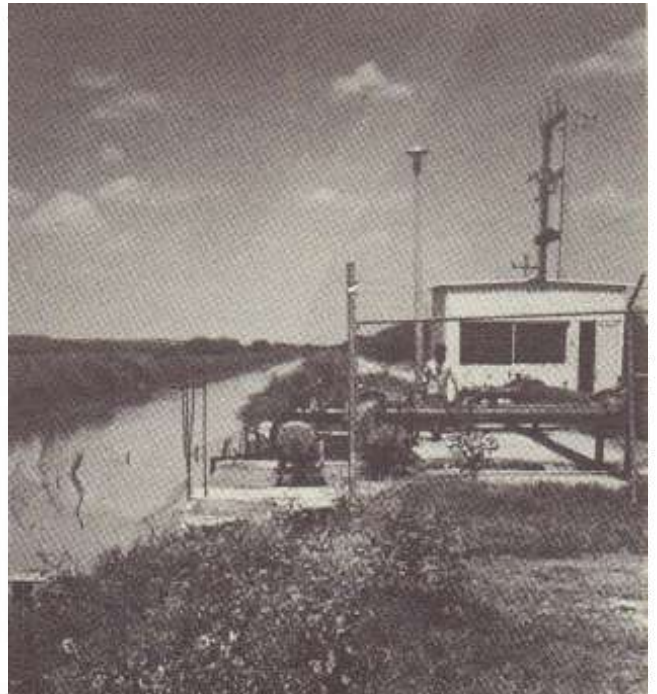
Estación de bombeo en Vaquerías.
