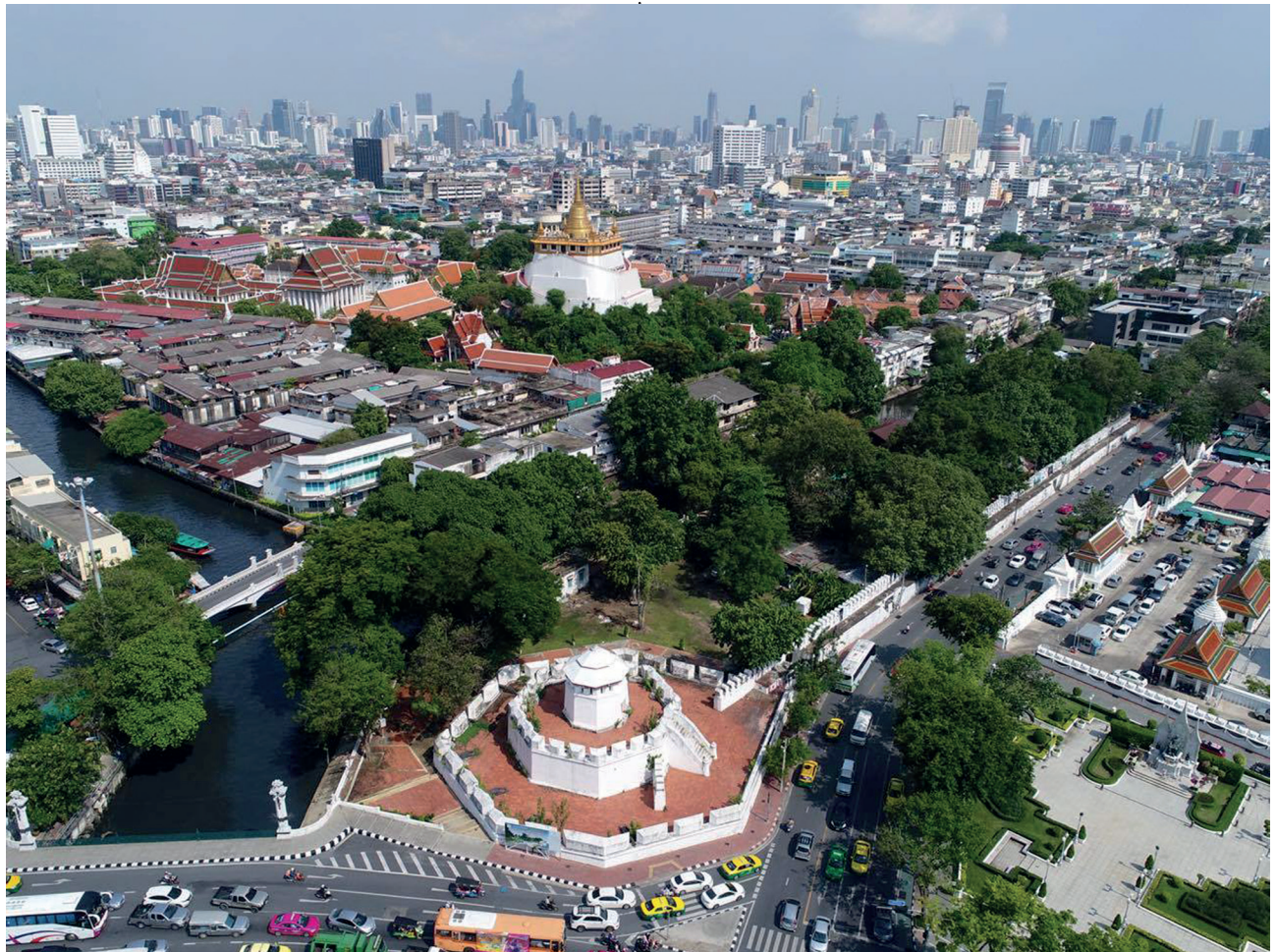
El fuerte Mahakan en un periodo reciente Fuente: Fotografía cortesía de Rungkit Charoenwat, VERNADOC Tailandia.
