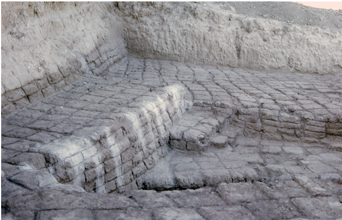
Figura 15. Sección del Ziggurat en Tell Omar, Irak, tras la aplicación de silicato de etilo en las paredes de adobe nuevas. Proyecto de investigación sobre la conservación de adobe, realizado por el ICCROM en colaboración con el Gobierno de Irak, el Instituto de Arqueología de la Universidad de Turín y el KIK-IRPA de Bruselas. Fotografía: Giorgio Torraca, 1970, Archivo del ICCROM.
