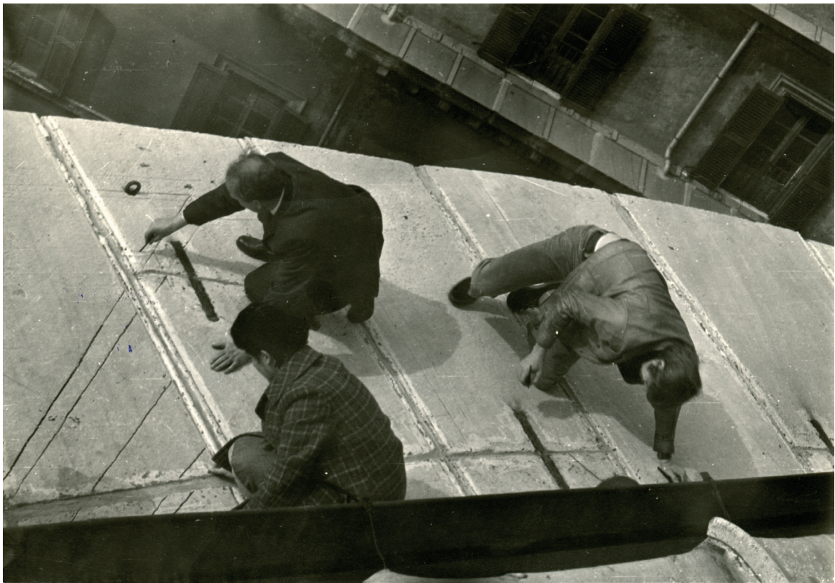
Figura 9: Participantes del curso ARC 1969-1970, dibujando las marcas del siglo XVII que fueron encontradas en la cubierta de plomo del Panteón. Estas marcas resultaron estar relacionadas con la construcción de las torres del siglo XVII de Bernini, que fueron demolidas a finales del siglo XIX, Archivo del ICCROM.
