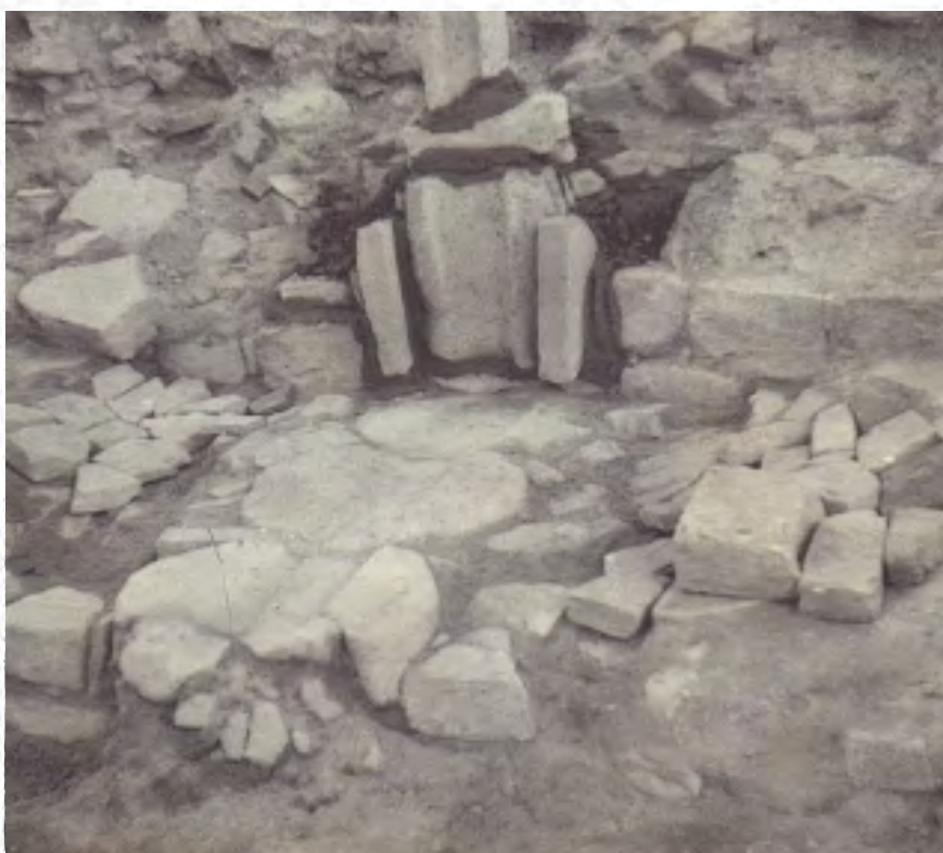
FOTO 5. DRENAJE SUPERFICIAL DE CILINDROS DE CANTERA VERDE CON ACANALADO
