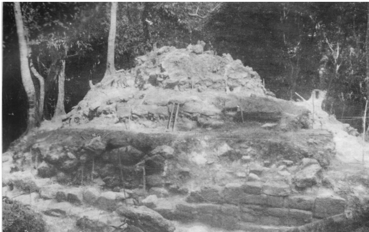
FOTO 2. ESTRUCTURA IV O "CIRCULAR" LIBERADA DE ESCOMBROS
