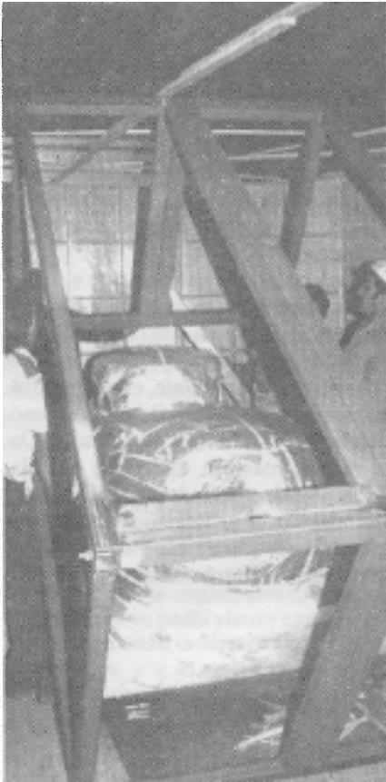
COLOCACION DE LA ESTRUCTURA DE LA CAJA DE EMBALAJE
