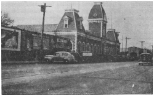
Edificio de la ex-aduana en la Ave. 16 de Septiembre
