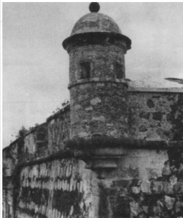
Ejemplo de garitón ("nido de golondrina") que existe en las terrazas de los fortines y baluartes. Se pueden apreciar las troneras desde donde se podía disparar y estar protegido al mismo tiempo.
