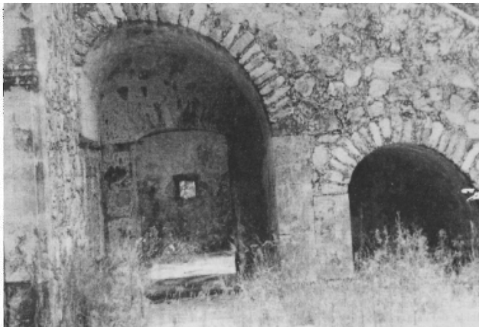
Espacios abovedados debajo de la rampa de acceso a la terraza.
