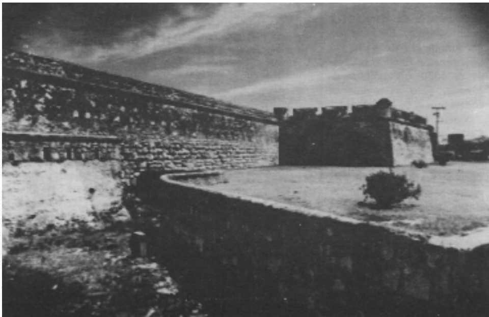
Vista parcial del lienzo de muralla y su unión con el Baluarte de San Francisco. Aún pueden verse las almenas y las troneras en el baluarte y la muralla, respectivamente.
