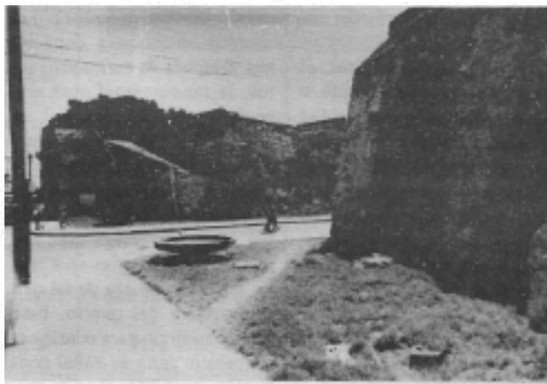
El Baluarte de San Francisco, después de su división en dos sectores. Puede apreciarse el pequeño talud de sus muros.
