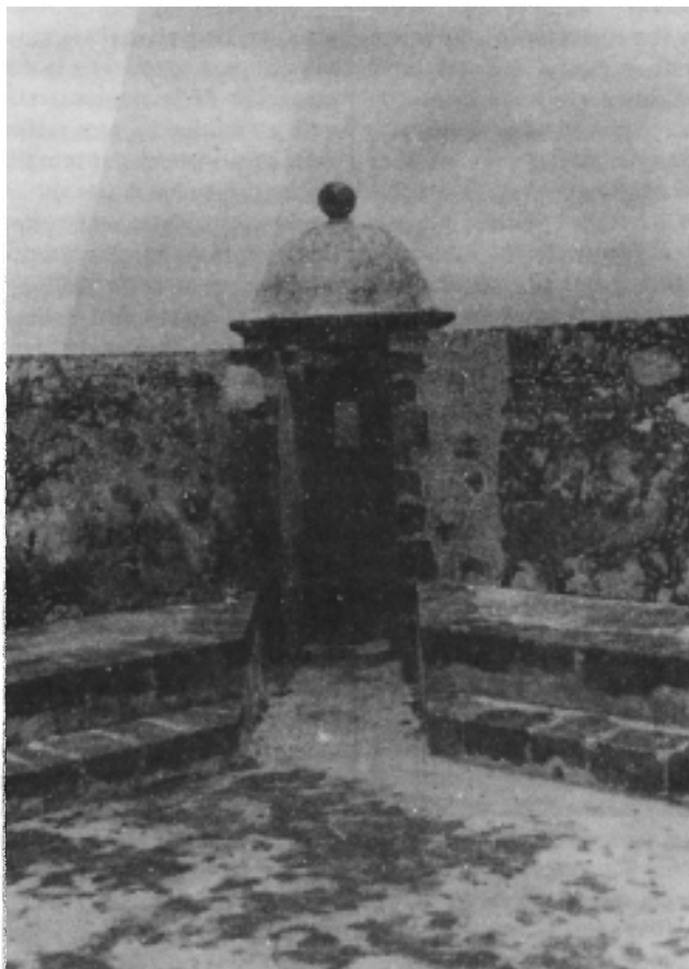
Vista posterior de un garitón donde se aprecia el acceso a éste; servían para vigilar y proteger el recinto amurallado. Desde ellos podía apreciarse la cercanía o lejanía del enemigo. Su espacio es muy pequeño, menor de 1 m 2 de superficie.
