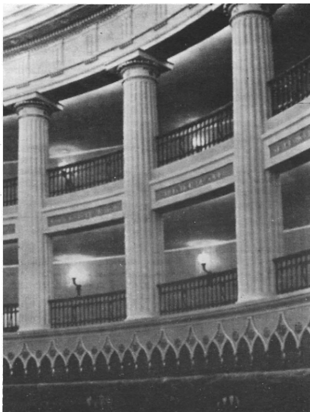
Restauración de la Sala del Congreso. Intercolumnio. Se determinó, en detalles y proporciones, de acuerdo a las normas de Vignola, lo que permitió el dimensionamiento de todos los elementos, a partir del número de columnas
