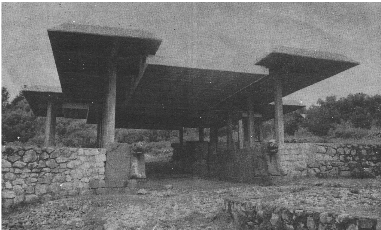
Cubierta de concreto en Kara Tepe, Turquía
