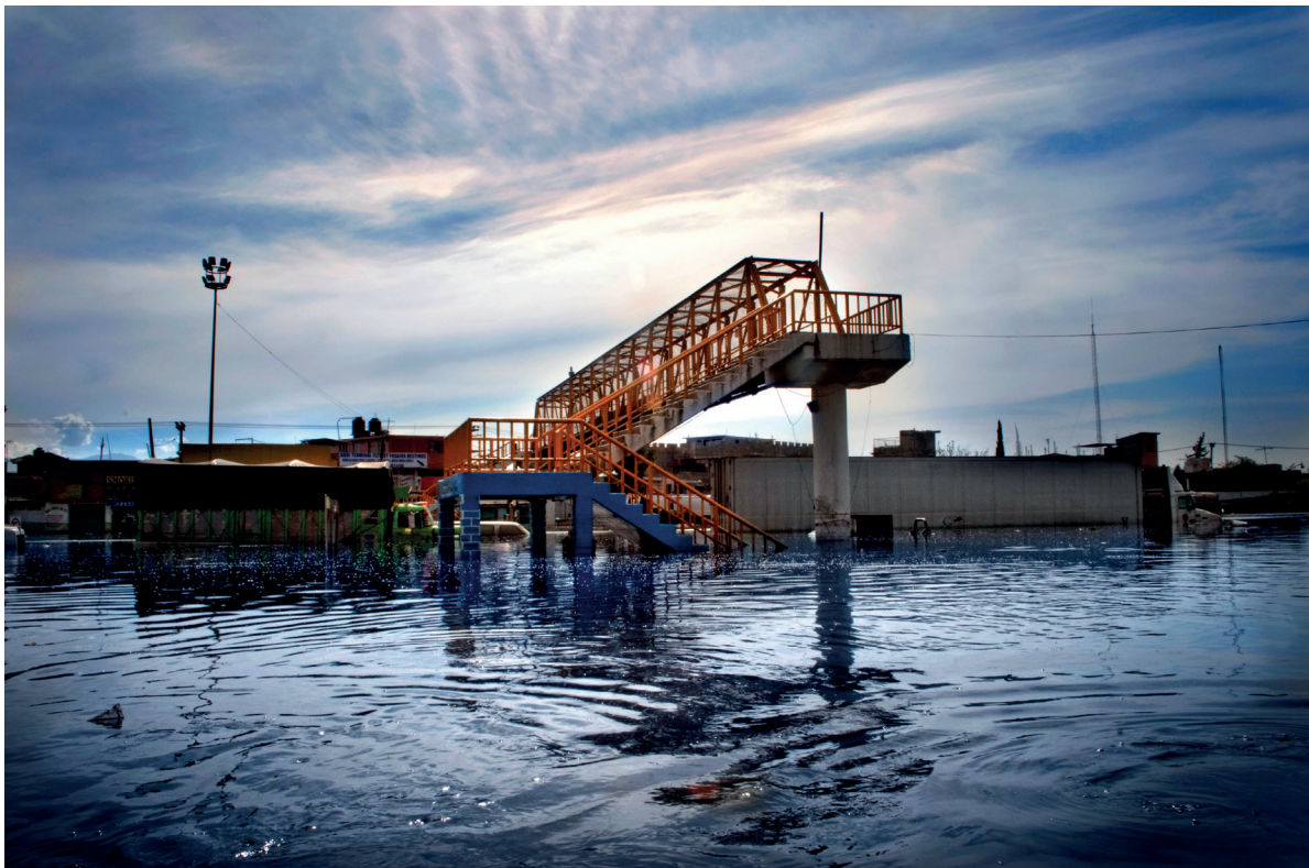
6. Un puente peatonal se mantiene como único testigo de la devastación sufrida en Valle de Chalco por el desbordamiento del río de La Compañía. Valle de Chalco, Estado de México, 2011. Fotografía: Lizeth Arauz.
