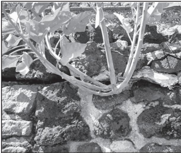
Figura 3. Deterioro muy agresivo del muro de contención de la plataforma interior sur, caracterizado por una grieta grande horizontal, un levantamiento de abajo hacia arriba con fracturación del mampuesto, producto del efecto expansivo de las raíces de tabaquillo adulto establecido por vástagos vegetativos, lo que implica necesariamente la eliminación del arbusto, seguida de trabajos menores de albañilería para restaurar el muro.
