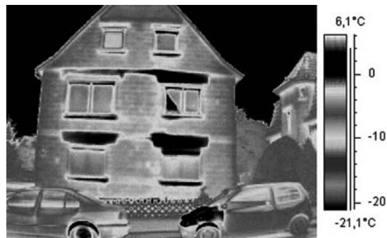
Figura 10. b) Termografía que muestra la fuga de calor de una casa. Tomado de http://www.aquitainethermographie.fr/photo_siteweb/localisation_de_ponts_thermiques_par_thermographie_infraroug.gif (consultado el 27 de abril de 2010).
