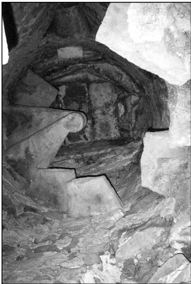
Figura 1. Restos de escalera conservados en el interior de la torre sur, vistos desde la parte inferior de la torre (Fotografía del autor).
