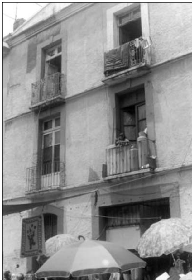
Fachada principal de la vecindad, que aún conserva sus rasgos arquitectónicos coloniales (fotos: Reyna Sánchez Estévez).
