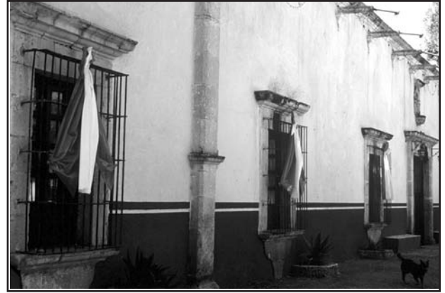
Figura 4. Fachada de la casa principal de la hacienda de Tayahua.
