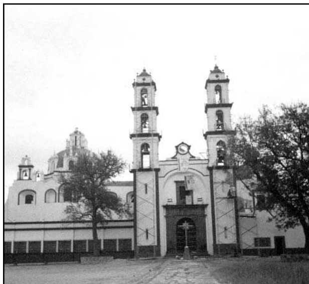
Figura 8. Estado actual del templo de Analco (Fotografía del autor).
