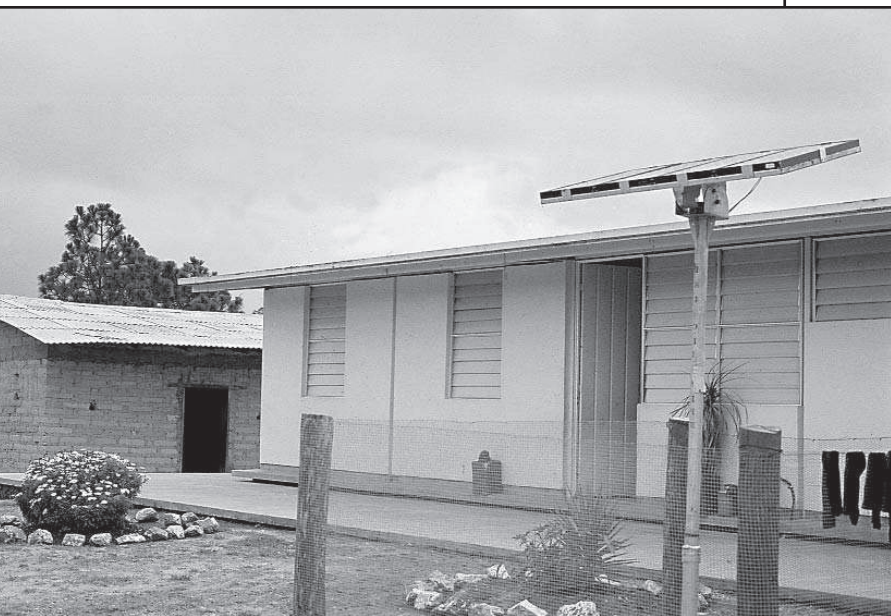
Tipo de construcción de un albergue escolar en El Duraznal, Ayutla Mixe, Oaxaca. Foto: Íñigo Aguilar Medina.
