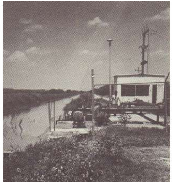
Estación de bombeo en Vaquerías.
