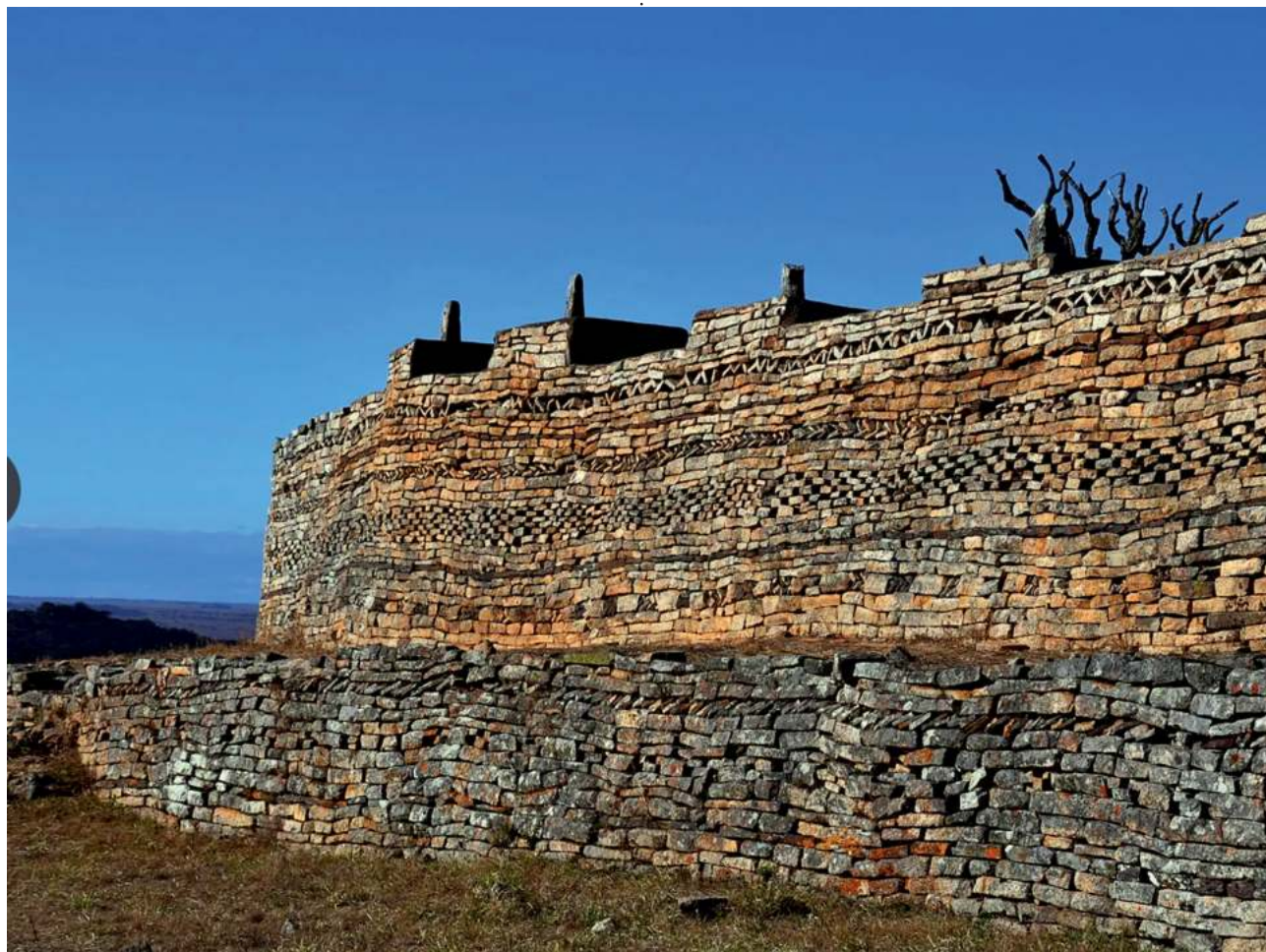
Detalle de muro en Khami. Imagen: Archivo del ICCROM.
