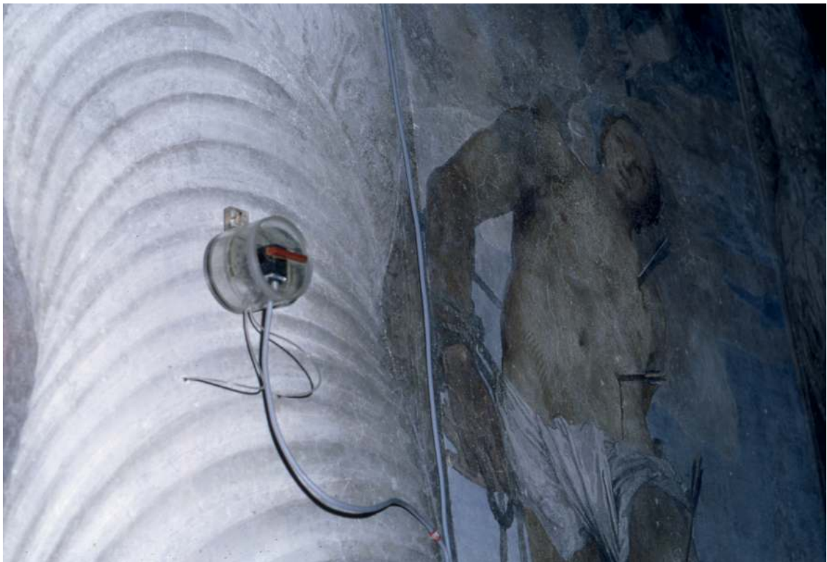
Figura 14. Sonda colocada en la iglesia de San Sebastiano de Venecia para medir el nivel de humedad de los frescos. Proyecto Vos, que preveía mediciones de la humedad durante un año con un equipo nuevo y automático. Este trabajo de investigación se practicaba en el marco de la Campaña Internacional para la Salvaguardia de Florencia y Venecia. Fotografía: Giorgio Torraca, 1968, Archivo del ICCROM.
