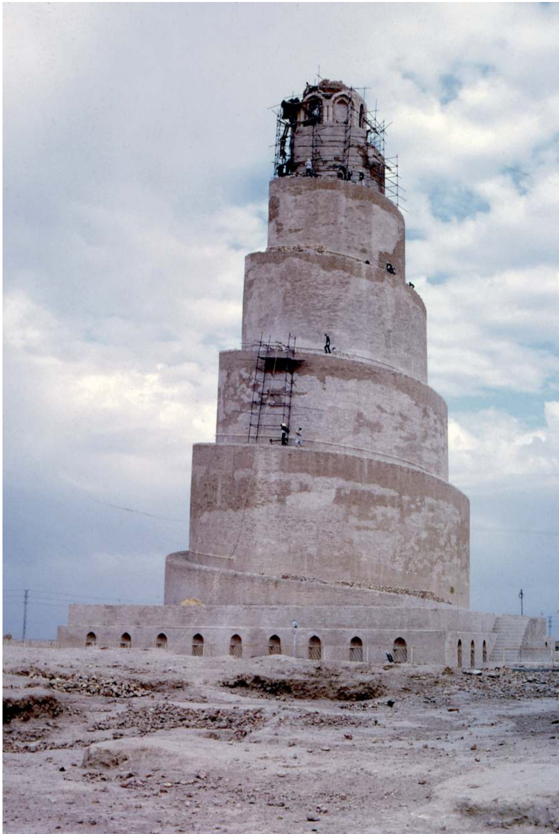
Figura 16. Minarete de la Gran Mezquita de Samarra, Irak. Proyecto de investigación sobre la conservación de adobe. Fotografía: Giorgio Torraca, 1970, Archivo del ICCROM.
