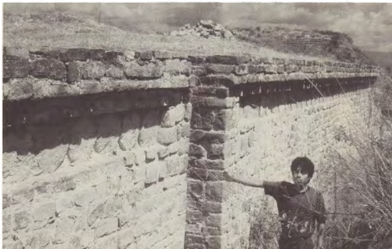
FOTO 8. DETALLE DEL MURO SUR DEL EDIFICIO "H" CON CILINDROS COMO FRISOS
