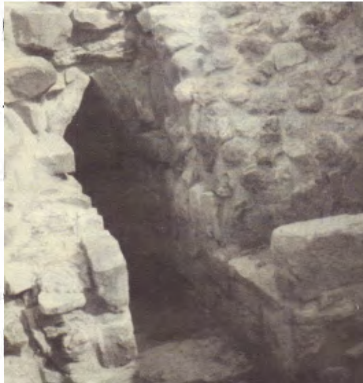
FOTO 1. VISTA GENERAL DE UN DRENAJE CON TECHADO DE BÓVEDA "ZAPOTECA"
