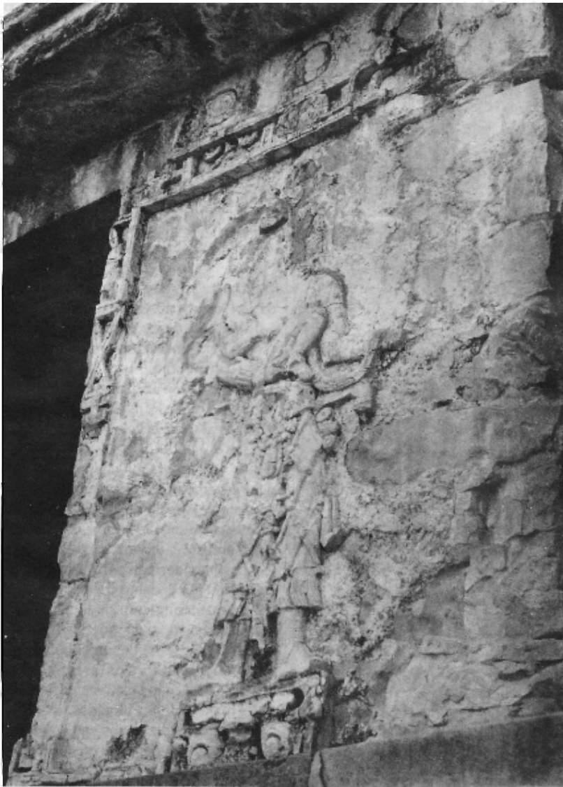
FOTO 5. TEMPLO DE LAS INSCRIPCIONES. PILASTRA ESTUCADA DEL LADO IZQUIERDO DE LA ENTRADA PRINCIPAL LIBERADA DE LOS CRECIMIENTOS ALGALES CON LA APLICACION DE BIOCIDAS. (FOTO: ARMANDO SOTO, JUNIO DE 1990)
