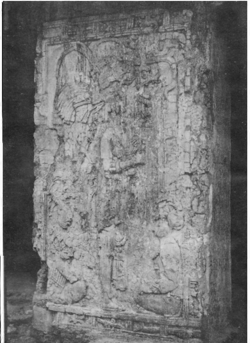
FOTO 4. EL PALACIO (CASA "A"). LOS CRECIMIENTOS ALGALES QUE SE LOCALIZABAN SOBRE LAS ORNAMENTACIONES DE LA CABEZA DEL PERSONAJE PRINCIPAL NUEVAMENTE FUERON CONTROLADAS CON EL USO DE BIOCIDAS. (FOTO: ARMANDO SOTO, JUNIO DE 1990)
