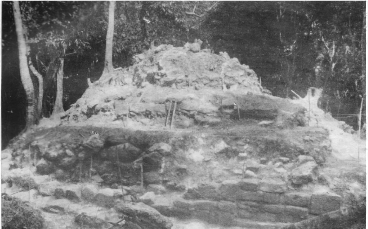
FOTO 2. ESTRUCTURA IV O "CIRCULAR" LIBERADA DE ESCOMBROS
