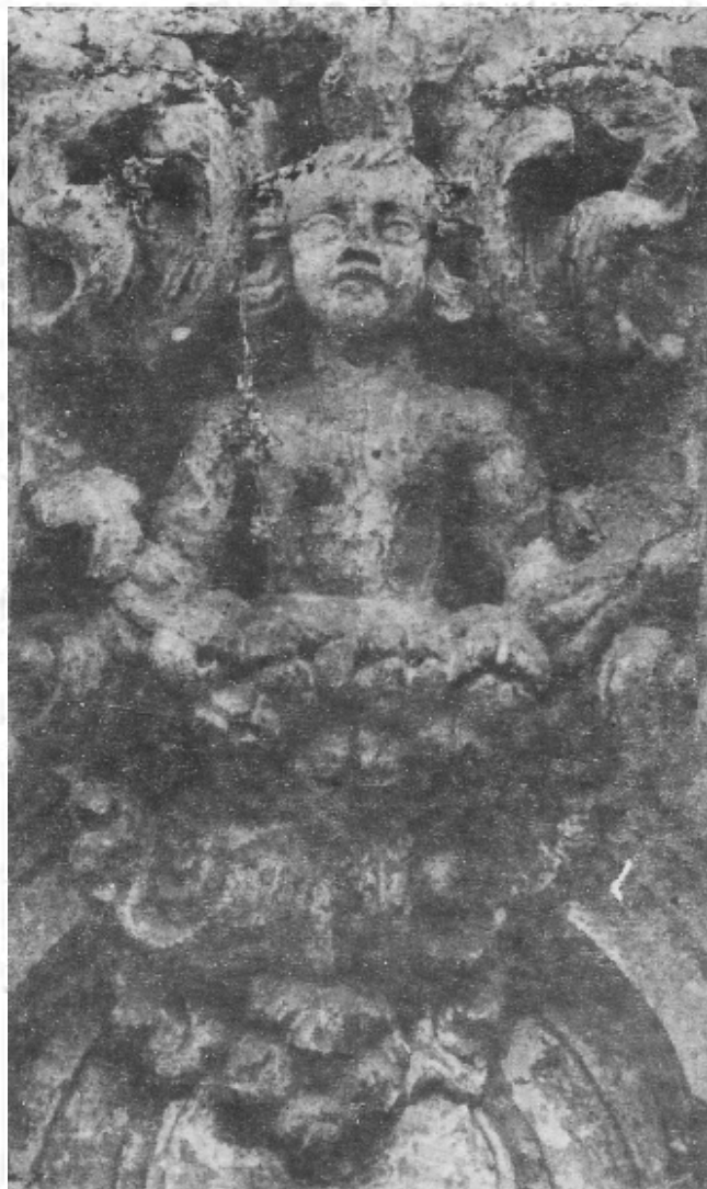
Abadía: detalle de la fachada
