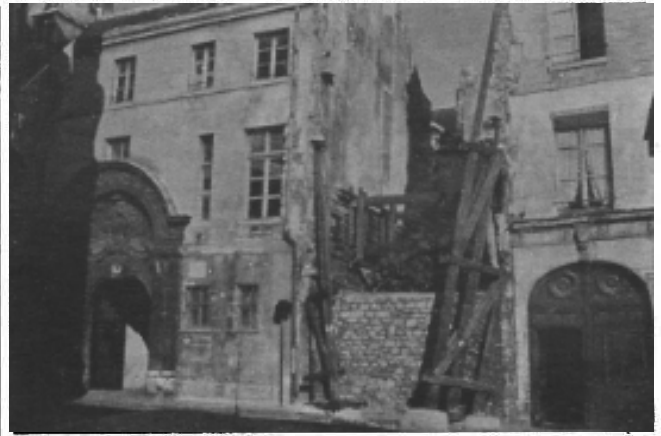
Apuntalamiento en el barrio del Marais, París, Francia, 1965
