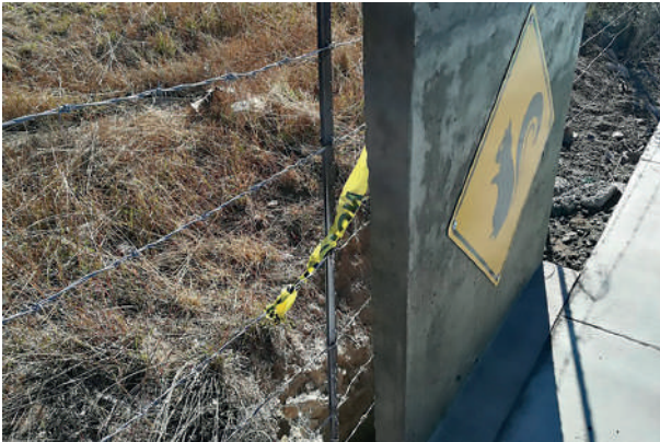
Figura 2. Paso de fauna. Fuente: Meléndez (2017b). Fotografía: Violeta Meléndez.
