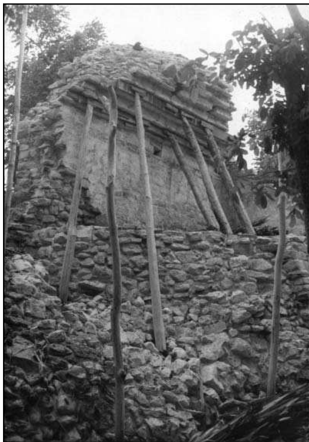
Figura 4. Restos de pintura mural en los cuartos destruidos de la Estructura 86 de Xelha.
