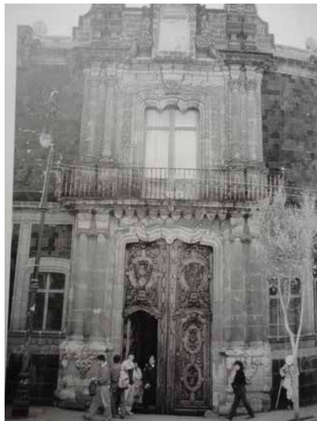
Figura 6. Fachada de la casa de los condes de Calimaya.
