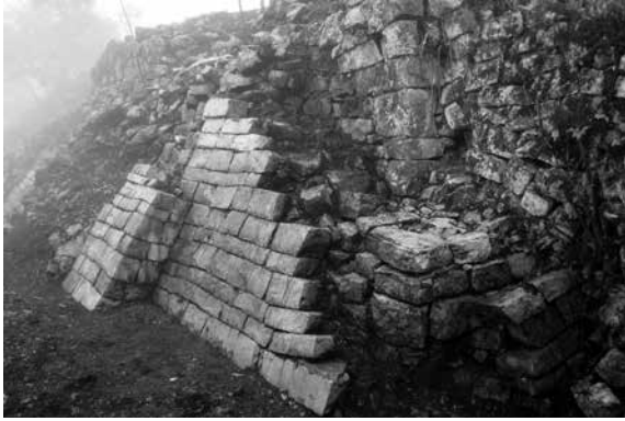
● Fig. 52. Vista esquina sureste donde se aprecian contramuros, aparentes y alfarda.
