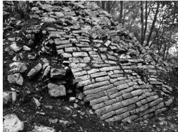
● Fig. 41. Vista al oriente del muro expuesto al sur del basamento.
