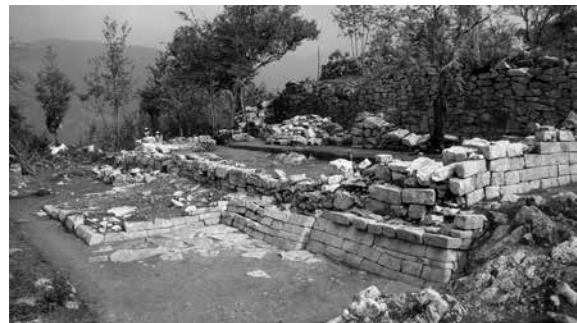
● Fig. 53. Vista hacia el noroeste de la estructura que cierra al norte la tercera terraza.
