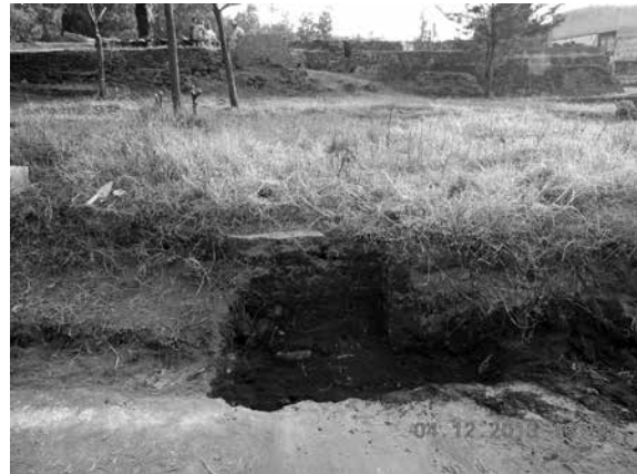
● Fig. 22 Vista general del muro norte de la Plataforma 3, donde se pueden apreciar los diferentes elementos que la componen.
