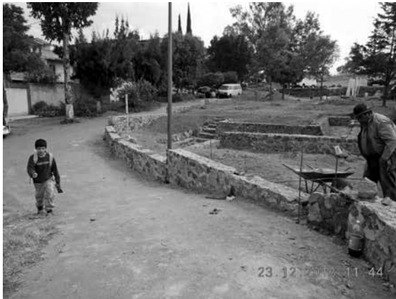
● Fig. 35 Construcción del muro base para la malla ciclónica en el extremo noroeste del sitio.
