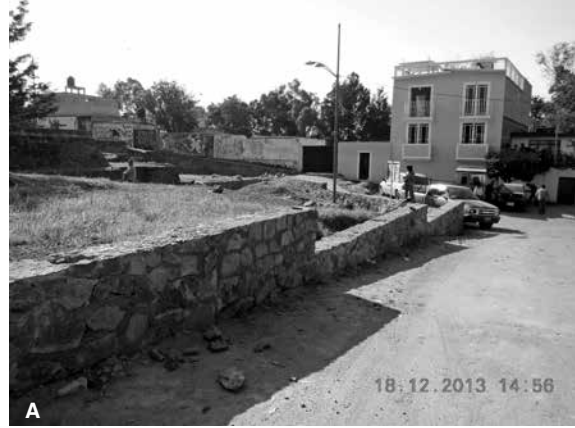
● Fig. 36A Muro de cimentación para la malla ciclónica terminado, en el extremo norte del sitio.
