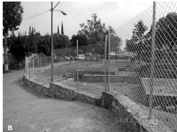
● Fig. 36B Aspecto final del muro perimetral en el extremo noreste de la zona.
