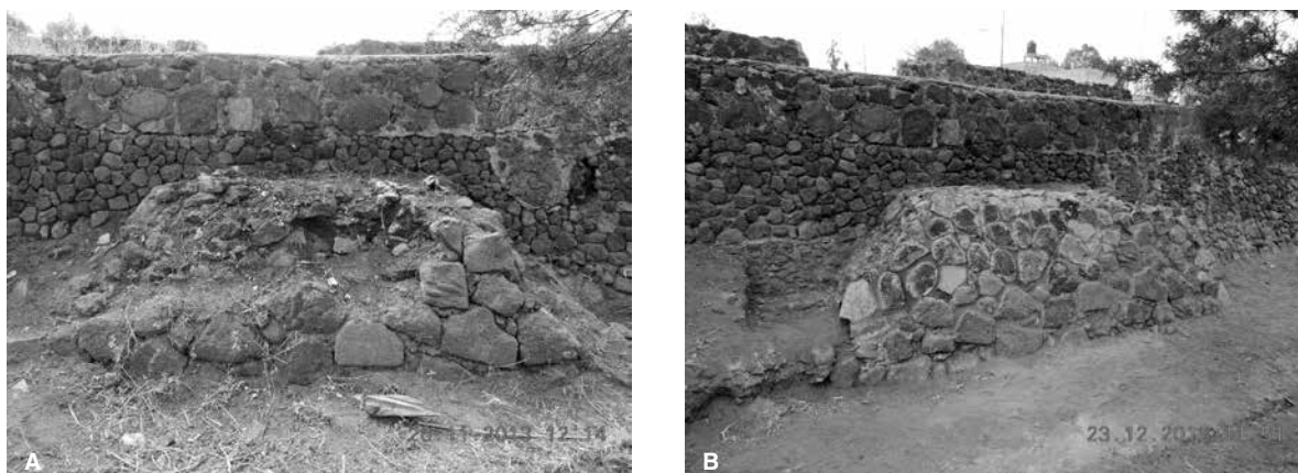
● Fig. 24 Segunda sección de muro antes y después de la intervención.
