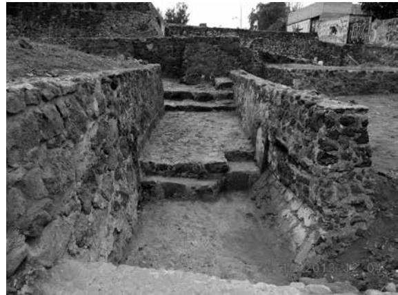
● Fig. 33 Vista general de Norte a Sur de la escalera 2 al terminar la consolidación.
