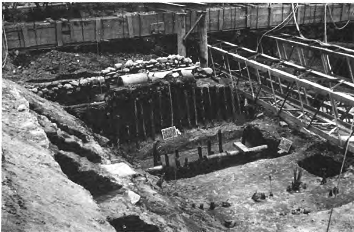
● Fig. 1 Pilotes correspondientes al sistema constructivo del Tezontlalli, tubería vidriada y drenaje porfiriano
