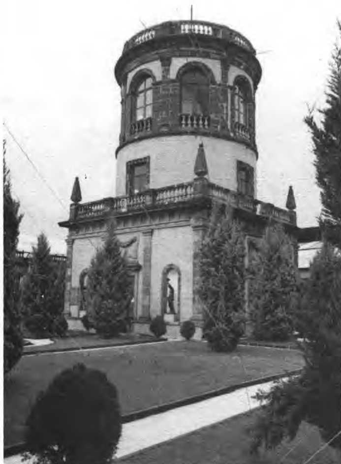
● Fig. 4 Fachada poniente del Caballero Alto al iniciar los trabajos.
