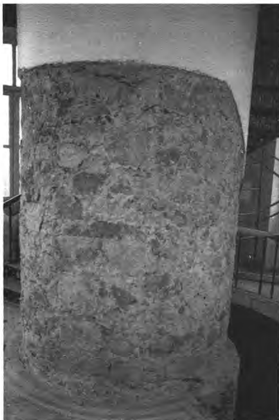
● Fig. 6 Arreglos posteriores a la columna central del Caballero Alto.
