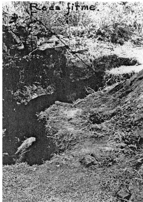
● Fig. 4 Excavación y cata número 3.
