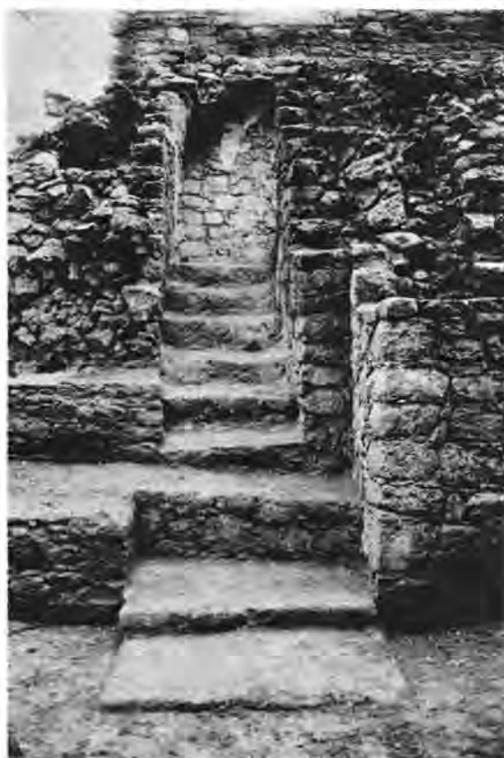
● Fig. 6 La escalinata remetida sur del cuerpo este.
