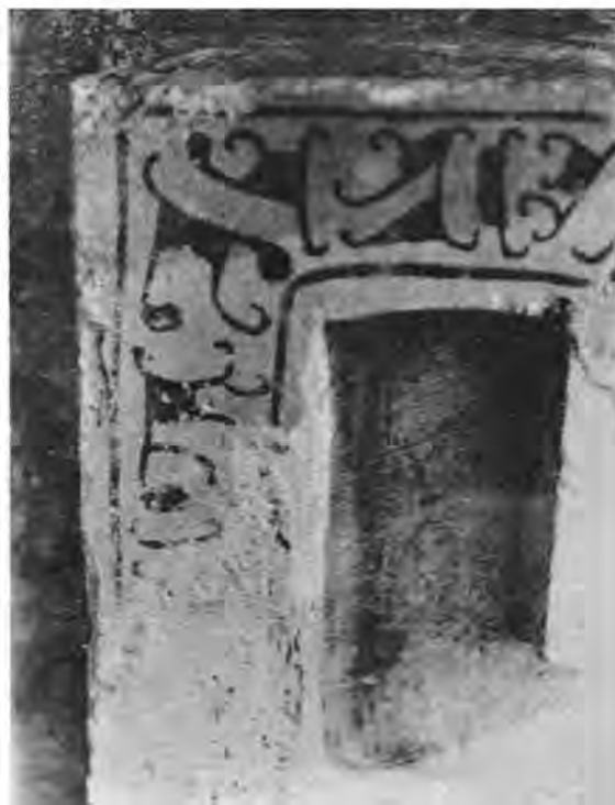
● Fig. 5 Detalle de la notable ornamentación al fresco que decoraba las grecas en la entrada de la pequeña escalera que penetra en el basamento del Edificio A del grupo Tajín Chico, ahora perdida a causa de la escasez de vigilantes.
