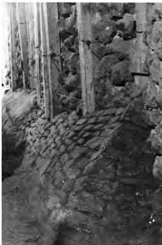
● Fig. 5 Esquina noroeste de la Estructura 1, construida de pequeños bloques de piedra tallada.
