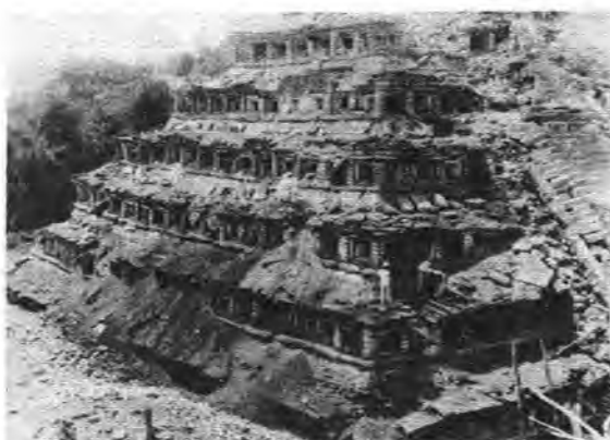
● Fig. 2 Ángulo sureste durante los trabajos de conservación (foto 16).
