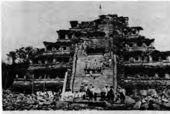
● Fig. 11 Lado este de la pirámide con alfarda reconstruida y parte de la escalera arreglada (foto 44).
