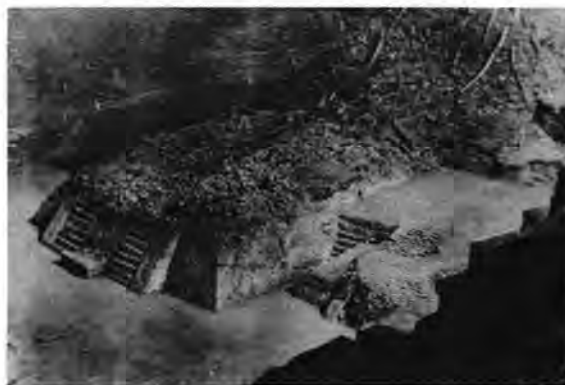
● Fig. 5 Aspecto de la construcción norte del Juego de Pelota después de los trabajos de 1935 (foto 8).
