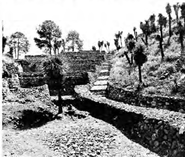
Figura 16. Calzada 1 con rampa escalonada hacia su extremo norte.
