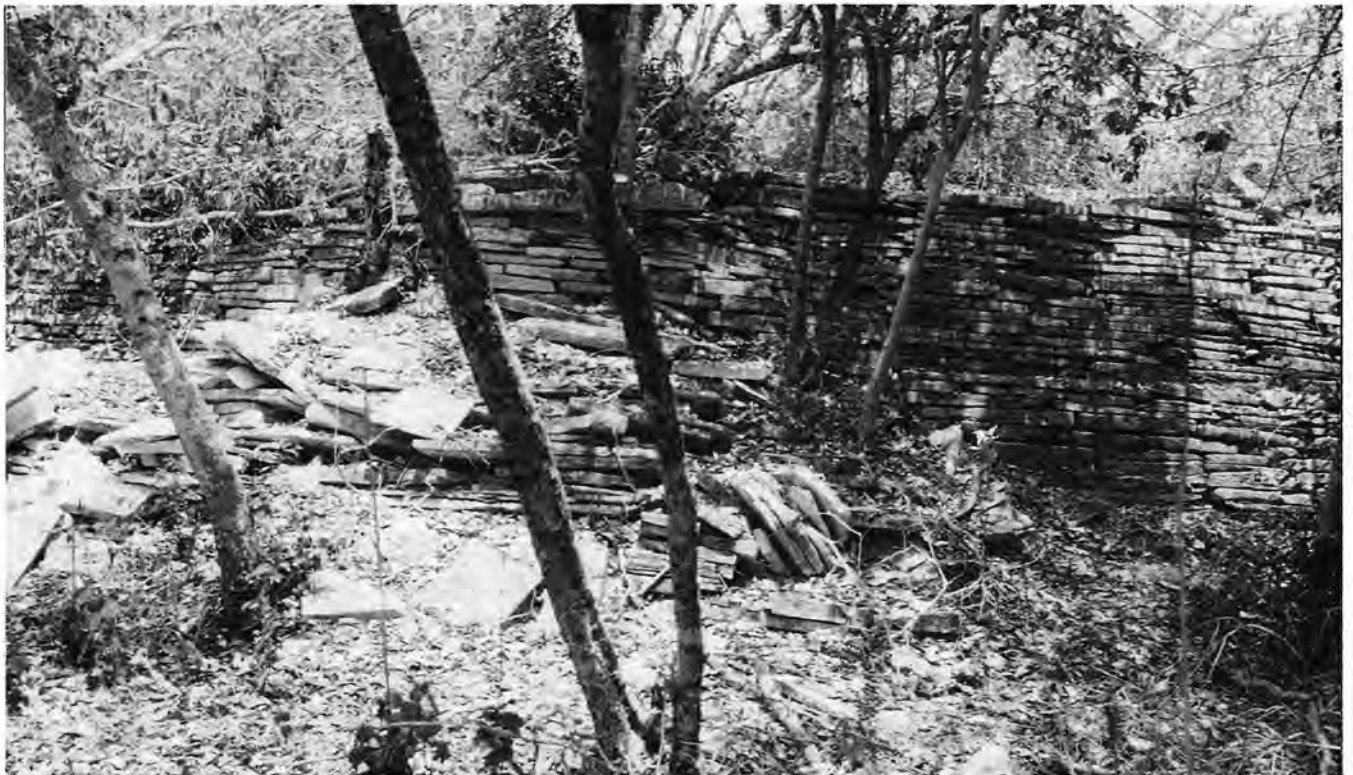
Figura 3. Basamento circular hecho con lajas calizas sedimentarias. Se advierte la parte de la escalera.
