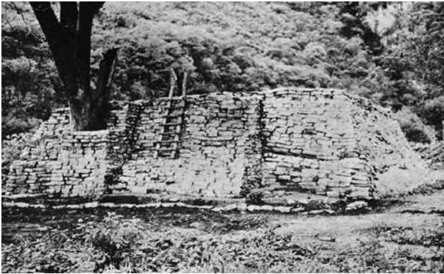
Fig. 4 Estructura principal del sitio El Sumidero (A-10) una vez restaurada.
