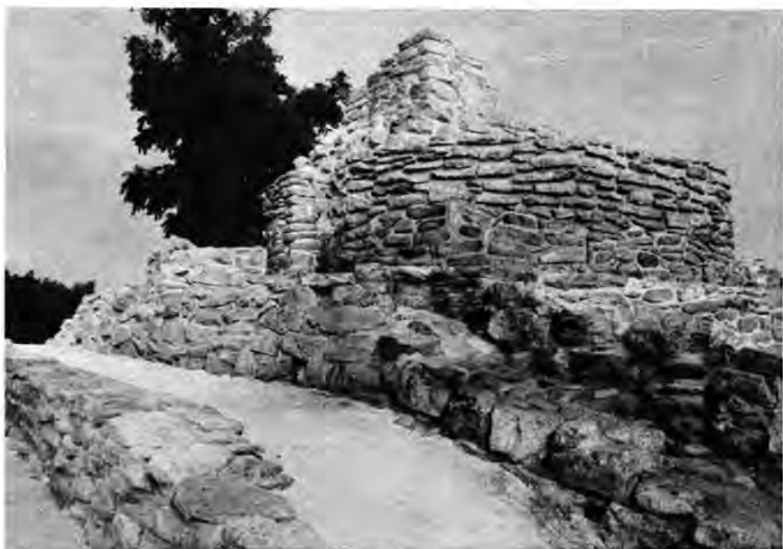
Figura 3. Un aspecto de la estructura P-III-Sub.
