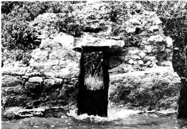
Figura 6. Estructura en el islote de Capechén, en la laguna del mismo nombre; presenta huellas de haber subido el nivel del agua casi a la mitad de la altura de la estructura.
