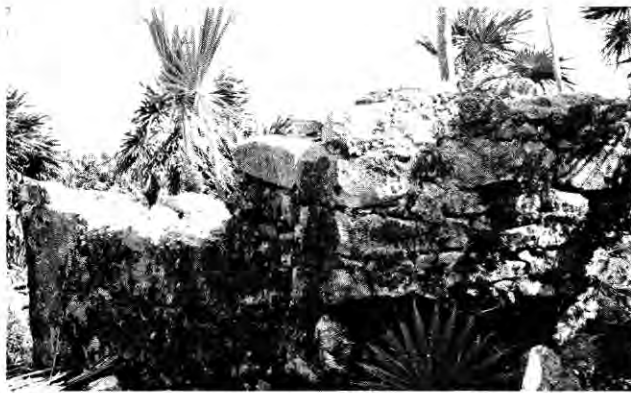
Figura 8. Restos de la estructura ubicada en la Punta Tulsayab.
