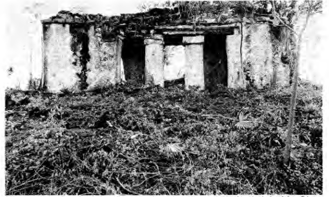
Figura 14. Parte superior de la estructura principal del sitio Chac Mool.
