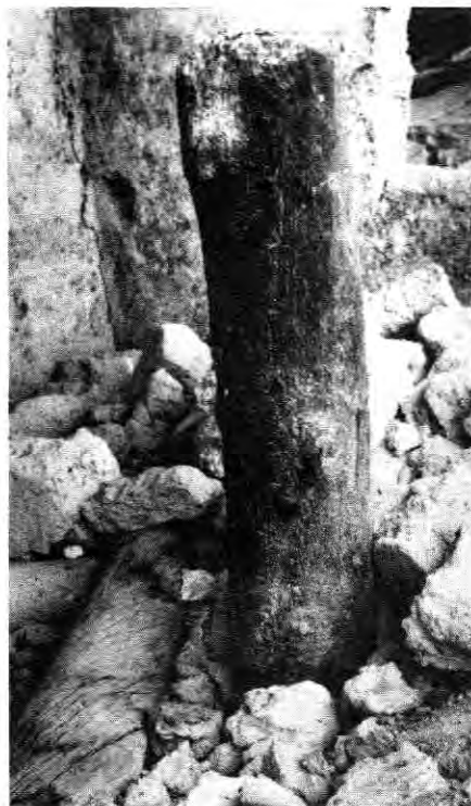
Foto 13. Sitio El Potrero. Poste Central in situ y viga maestra caída de la Cueva 3 del Cuarto 4. Ambos de 30 cm de diámetro.
