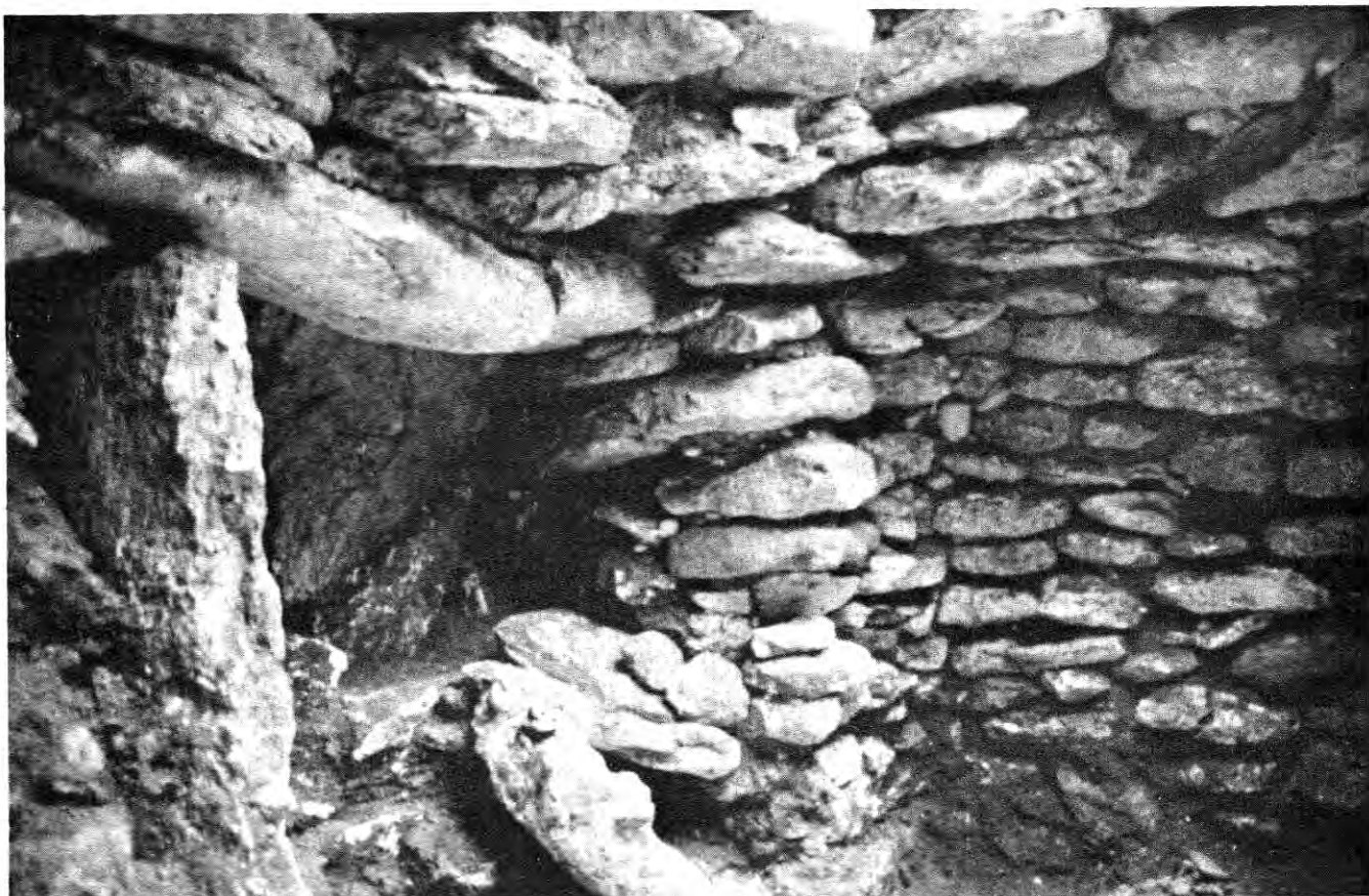
Foto 1. Acceso a la Tumba 1, visto desde el interior.
