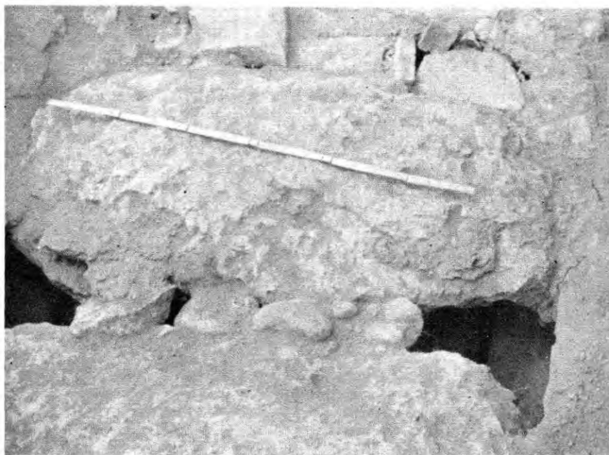
Foto 2. Detalle del sistema constructivo de la cubierta.
